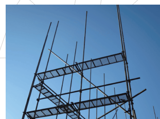
足場架設、解体工事
